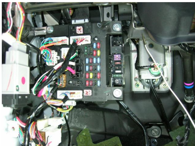
Boîte de fusibles
